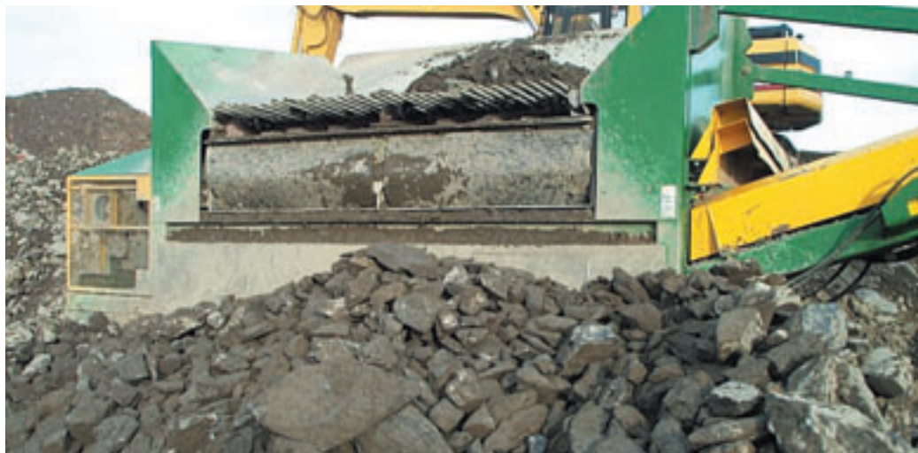
△ Sikting av gravemasser for jordproduksjon
