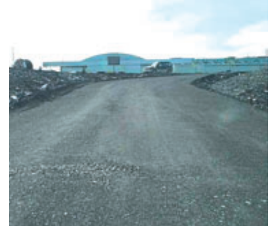
△ Knust asfalt, ferdig utlagt og kompaktert
