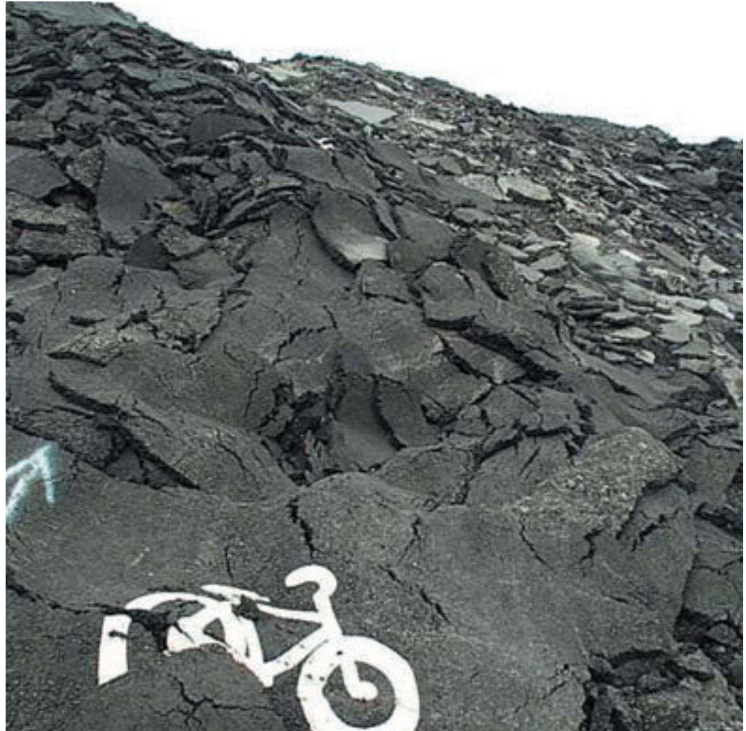
△ Oppgravd asfalt på Fornebu
