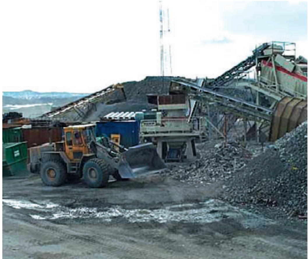
△ Produksjon av pukk, knust asfalt og knust betong ved gjenvinningsanlegget
