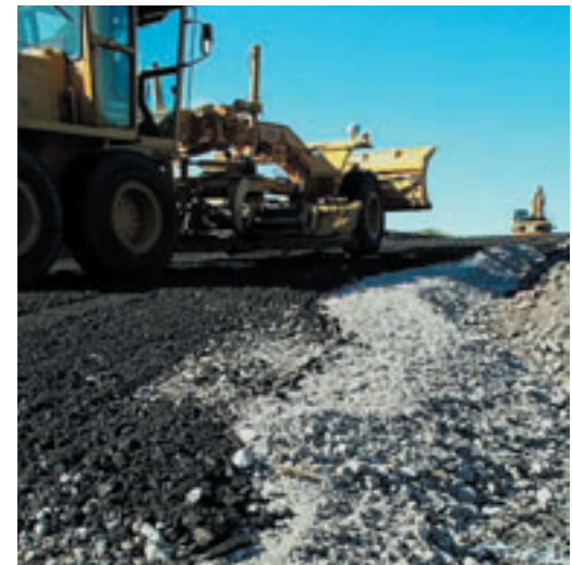
Utlegging av knust betong og knust asfalt i adkomstvei nord på Fornebu >
