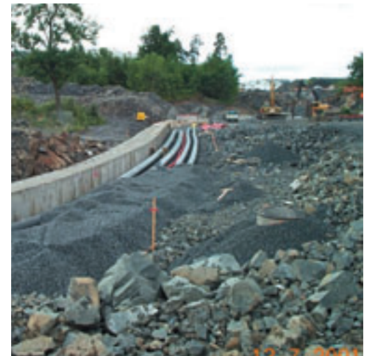
▽ Utlegging av grøftemasser
